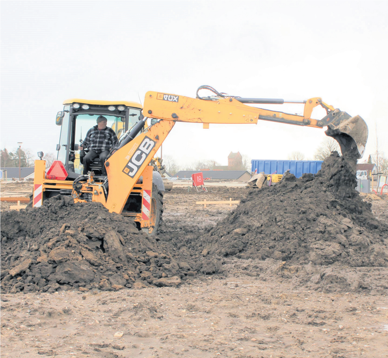
Første spadestik - bogstaveligt talt. eurodan-huse er igang med at grave fundamentet ud til huset.
